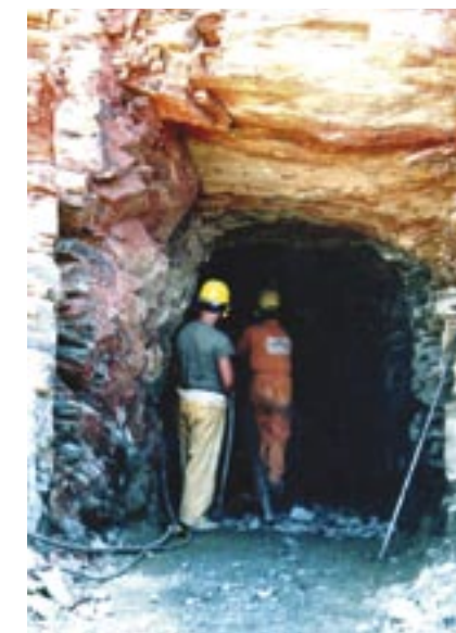
Creusement de la galerie artificielle d'Alqueva, Portugal.
