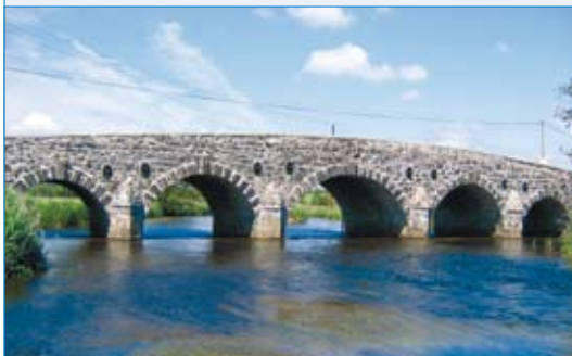
Illustration 21. Lisconny Bridge, Irlande, après restauration. © C. Shiel
