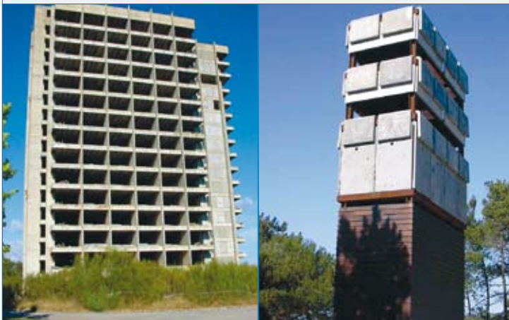
Illustration 19. Ancien et nouveau gîtes de Tadarida , Portugal. a) Bâtiment d'origine. b) Nouveau gîte. © M. Carapuço © J. Palmeirim
