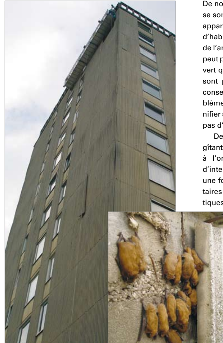
Illustration 12. Immeuble d'habitation en Slovénie où un gîte de Nyctalus noctula n'a été découvert sous le revêtement extérieur que lorsque les travaux de rénovation ont commencé. © P. Presetnik
